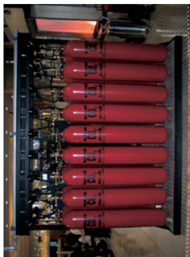
Impianto ad anidride carbonica
